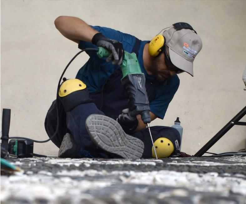
Fig. 46. Operazioni di micro-demolizione con trapano tassellatore.
