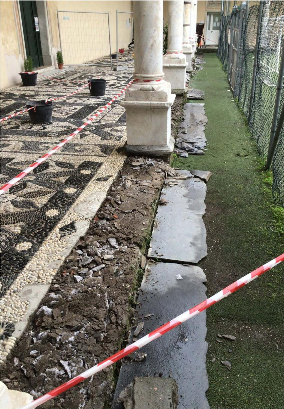
Fig. 42. La sostituzione delle ardesie.
