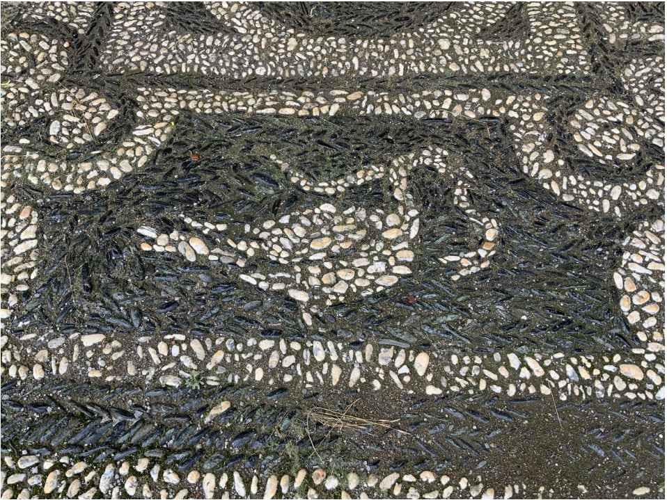
Fig. 36. Quadrante 28 prima del restauro.
