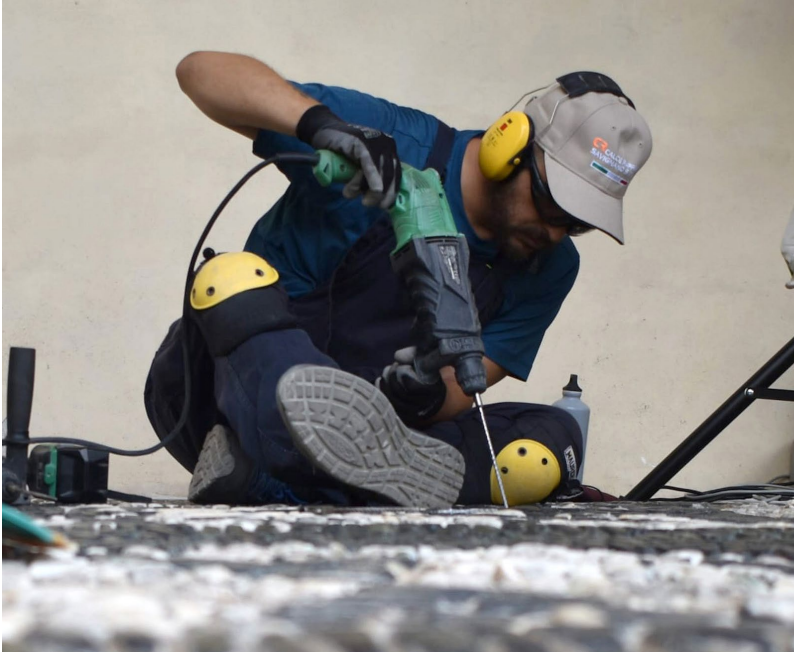
Fig. 46. Operazioni di micro-demolizione con trapano tassellatore.
