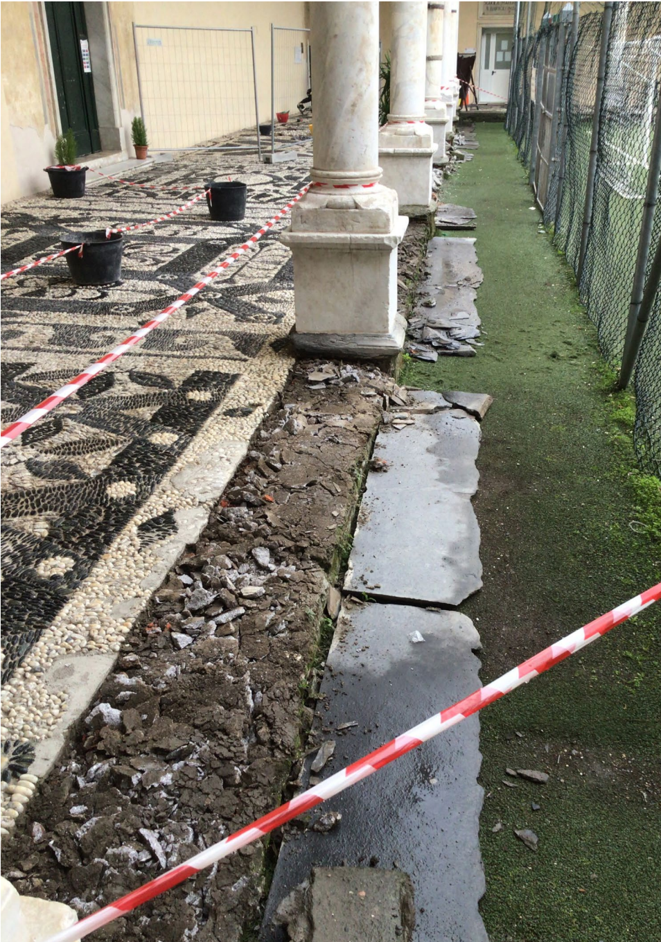
Fig. 42. La sostituzione delle ardesie.
