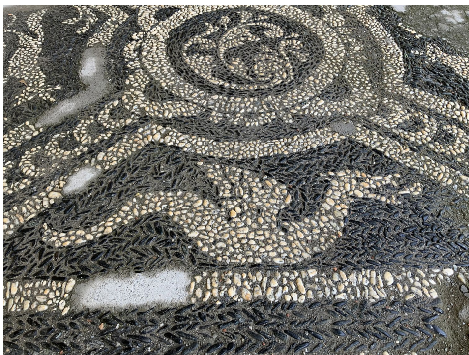
Fig. 34. Quadrante 27 prima del restauro.
