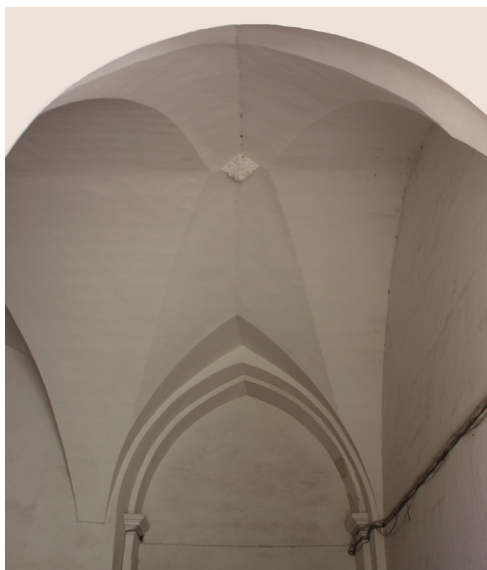
Fig. 4. Convento degli Scolopi in Manduria (TA): sistema voltato a stella su impianto rettangolare irregolare, con finitura superficiale a scialbo di calce e sesto acuto (1696-1745; foto 2021, Ilaria Pecoraro).
