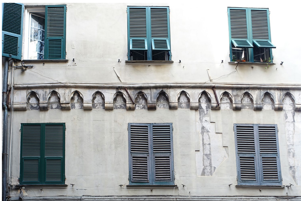
Fig. 9. Archetti pensili in pietra. L'arco a sesto acuto presenta un motivo decorativo al suo interno.
