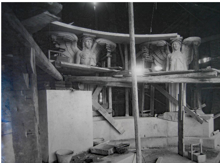
Fig. 34. Prova di montaggio di una parte con cariatidi del Monumento ai Caduti di Casale Monferrato presso il Laboratorio Nicoli a Carrara.
