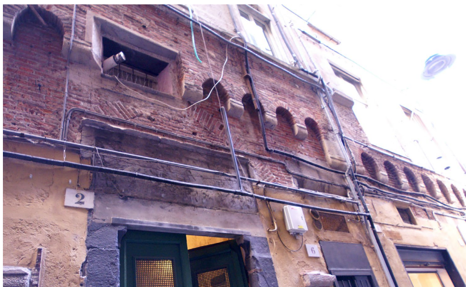
Fig. 8. Archetti pensili in mattoni su mensole stondate di pietra in via della Maddalena.
