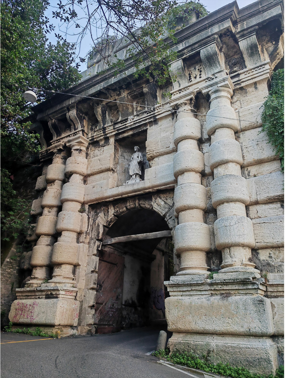
Fig. 12. Porta degli Archi, realizzata nel 1536 con pietra di Finale.
