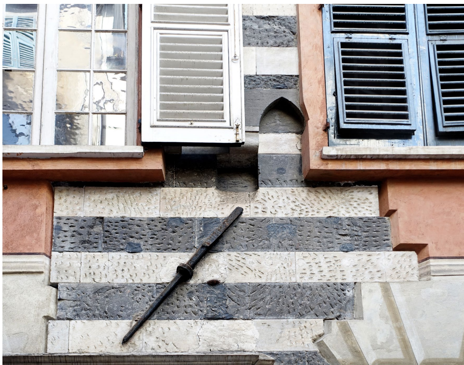
Fig. 15. L'alternanza sul paramento murario dei blocchi in marmo di Carrara e della pietra nera di Promontorio.
