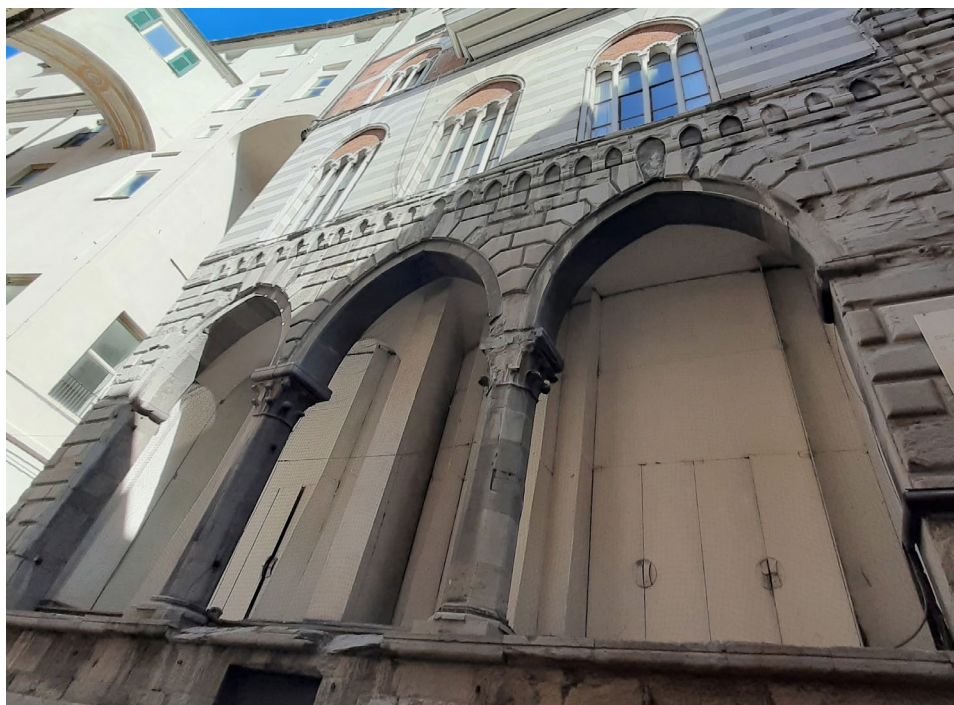
Fig. 14. La grande loggia in via Tomaso Reggio, realizzata in pietra di Promontorio, riaperta e restaurata negli anni '30 del XX secolo.
