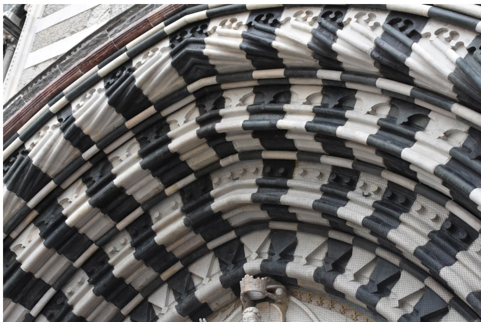
Fig. 6. Particolare della raggiere centrale eseguita il marmo apuano e Peridotite Nera.
