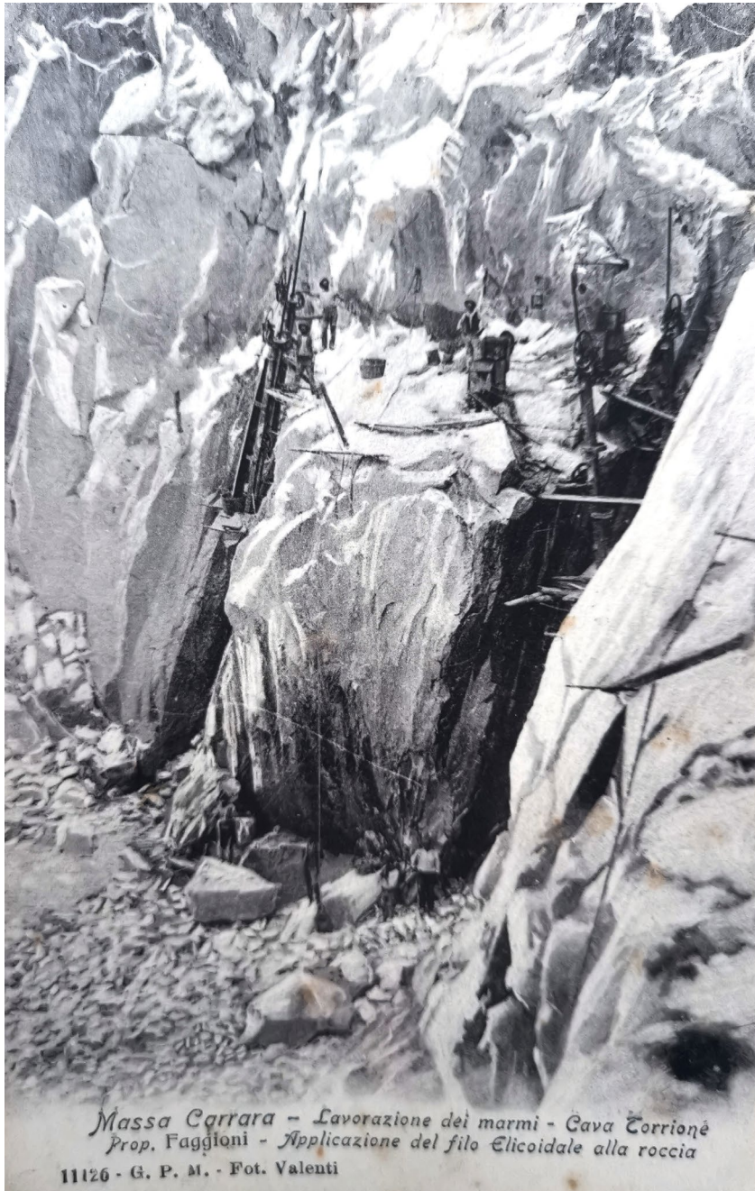
Fig. 29. "Massa Carrara – Lavorazione dei marmi – Cava Torrione (Carrara), proprietà Faggioni, Applicazione del filo elicoidale alla roccia", foto Valenti.
