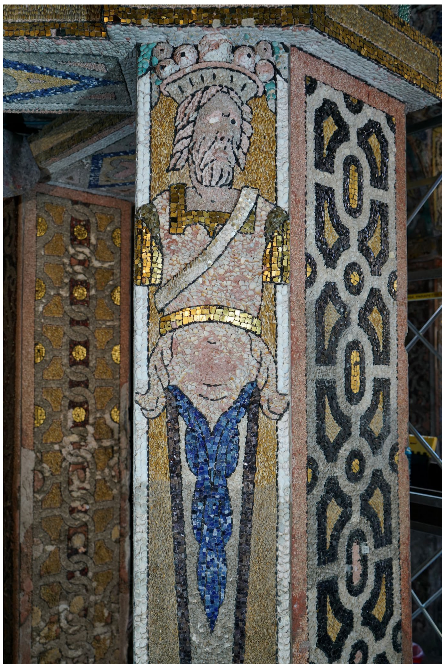
Fig. 4. Pilastro con telamone durante la pulitura eseguita nell'ambito del progetto pilota condotto dall'Opificio delle Pietre Dure (©MiC, SABAP MET GE).
