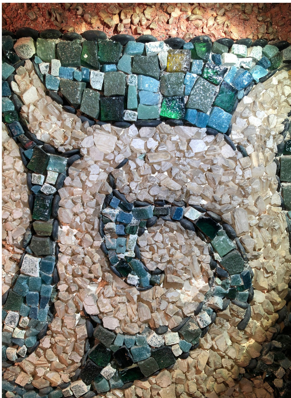
Fig. 14. Particolare del pilastro 1A: campitura azzurra in pasta vitrea con alcune tessere in pasta vitrea trasparente (verde e ambrata) con l'oro rivolto verso la malta di allettamento (©MiC, OPD).
