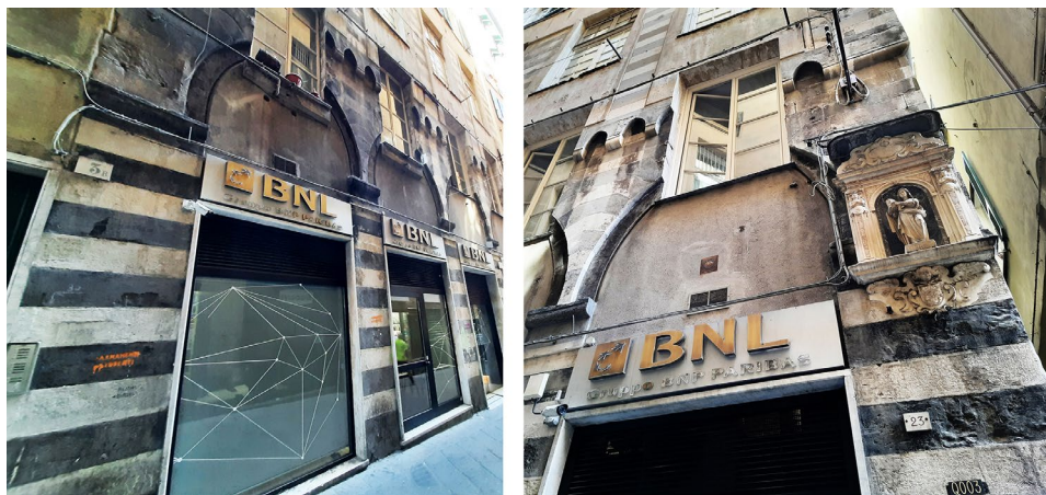
Fig. 4. Loggia in via San Luca. Il paramento bicromo caratteristico dell'edilizia medievale genovese si estendeva talvolta dal porticato fino ai piani superiori.
