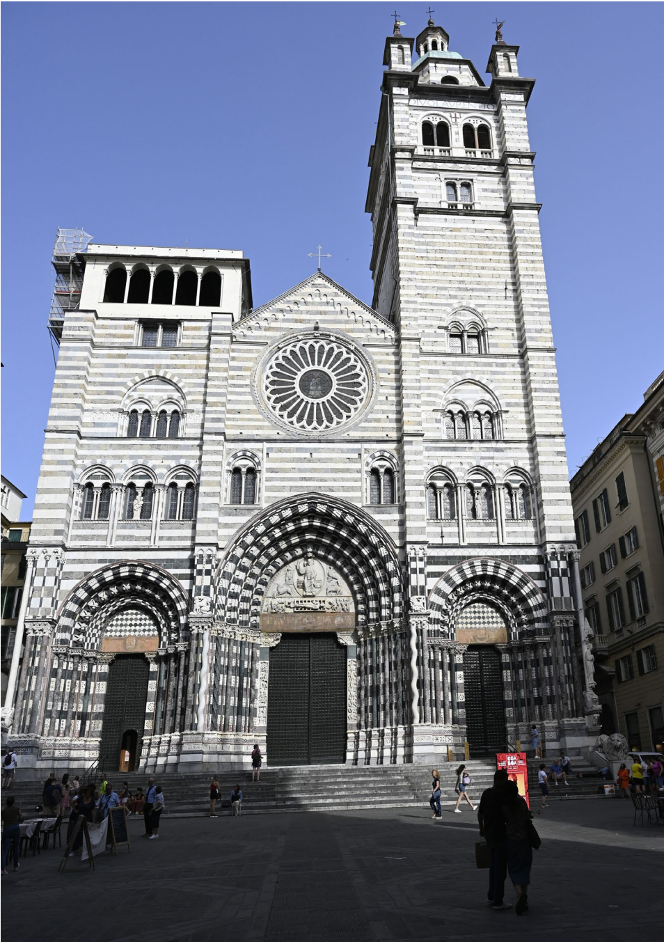
Fig. 1. Il fronte occidentale dopo il restauro.
