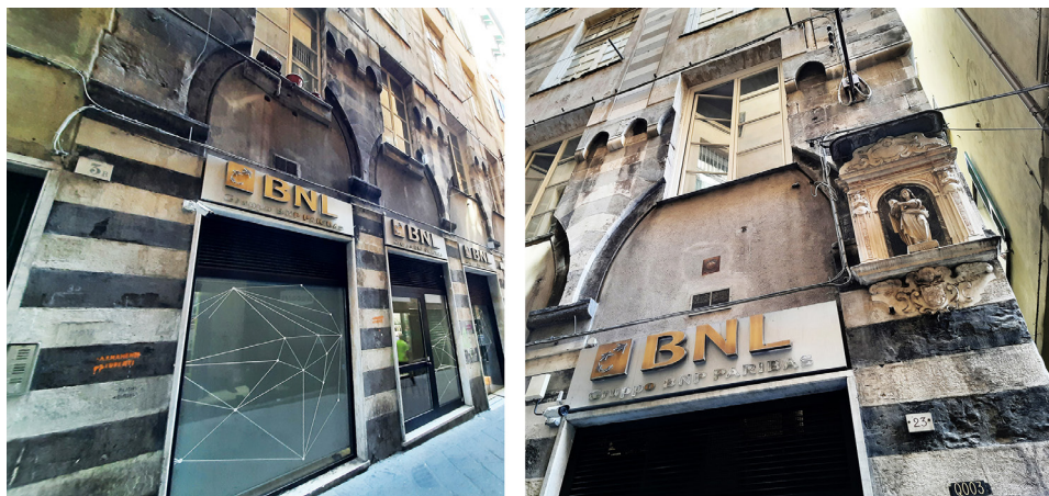
Fig. 4. Loggia in via San Luca. Il paramento bicromo caratteristico dell'edilizia medievale genovese si estendeva talvolta dal porticato fino ai piani superiori.
