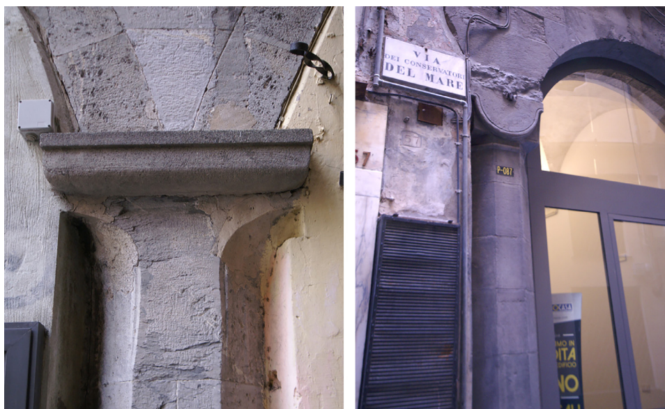
Fig. 6. Capitelli e colonne in pietra: una semplice mensola di appoggio in vico dei Notari (a sinistra); un capitello di forma geometrica in pietra di Promontorio in via dei Conservatori del Mare (a destra).
