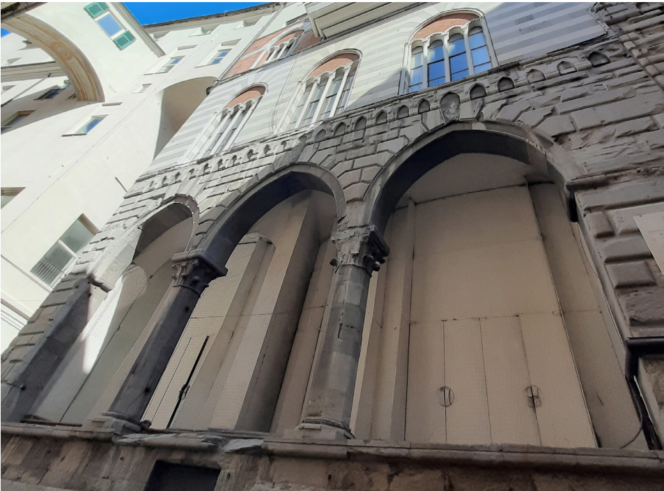
Fig. 14. La grande loggia in via Tomaso Reggio, realizzata in pietra di Promontorio, riaperta e restaurata negli anni '30 del XX secolo.
