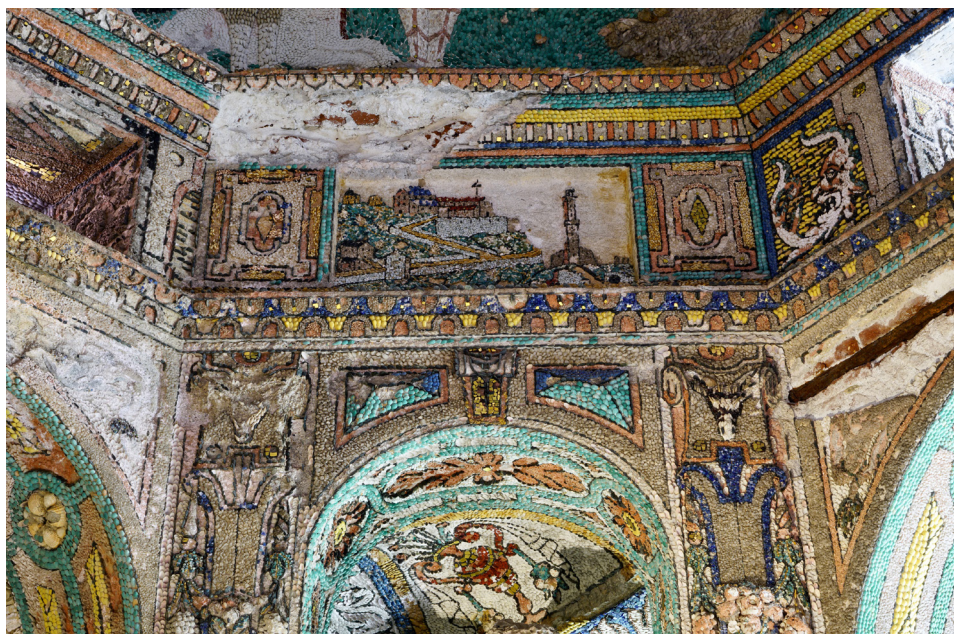
Fig. 12. Particolare del rivestimento polimerico del tamburo dove si osservano, tra gli altri materiali, tessere di maiolica in vari colori (©MiC, SABAP MET GE).
