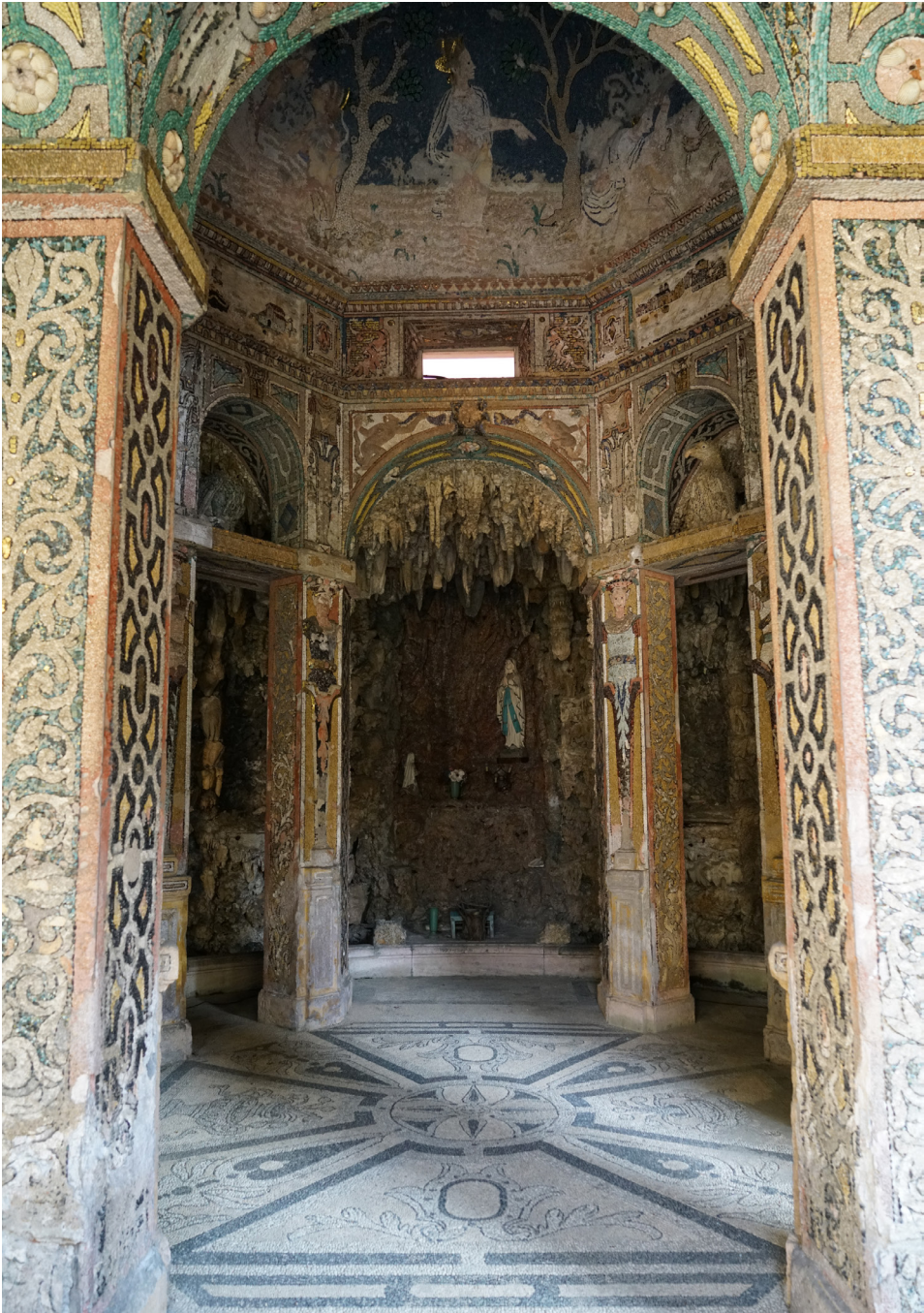
Fig. 1. Grotta Pavese, veduta generale dell'ambiente centrale (©MiC, SABAP MET GE).
