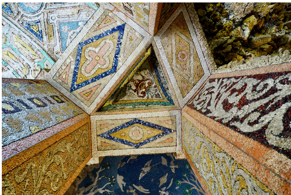
Fig. 13. Particolare di pilastri e trabeazione che presentano, tra gli altri materiali, campiture in pasta vitrea di vari colori (©MIC, SABAP MET GE).
