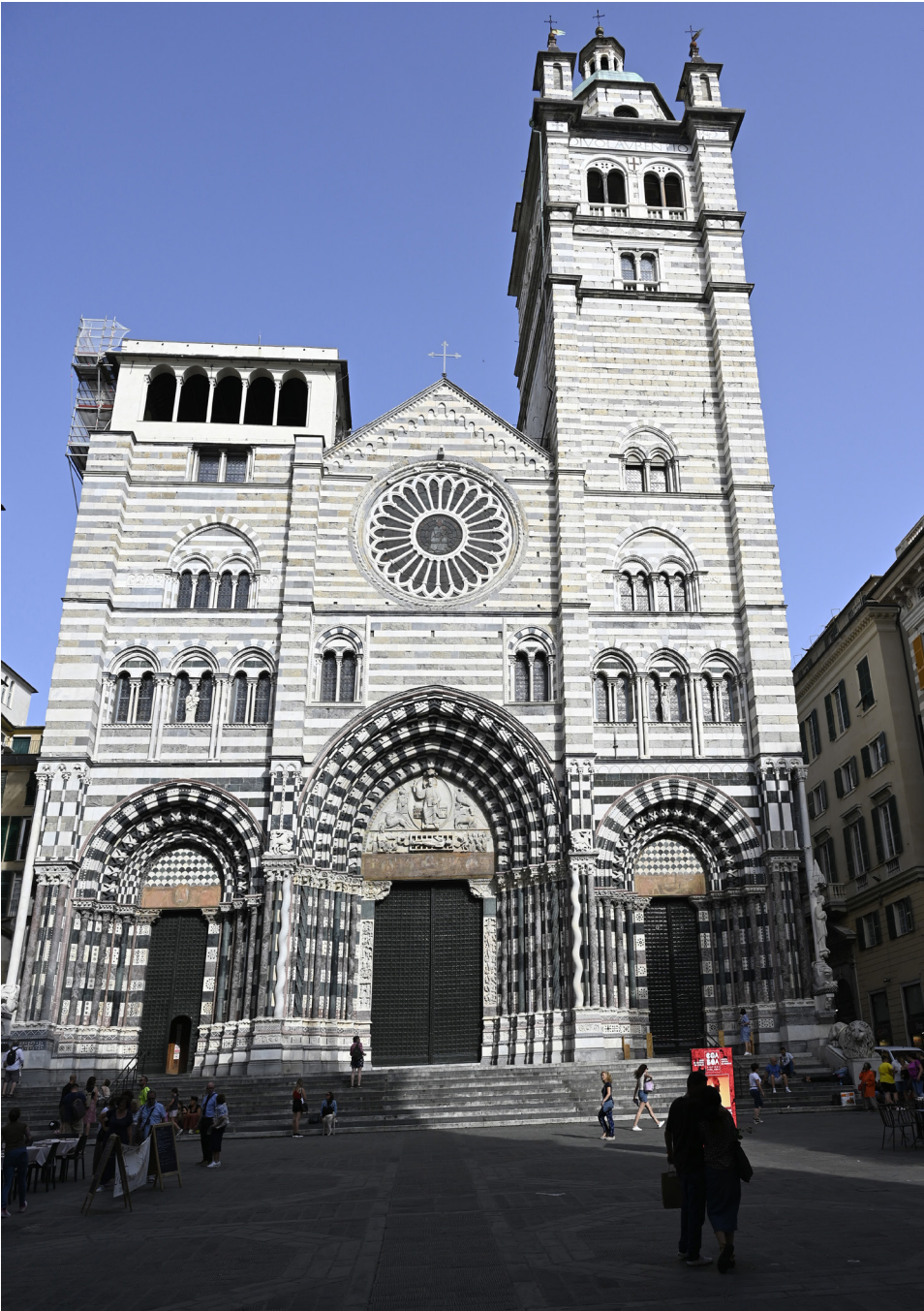
Fig. 1. Il fronte occidentale dopo il restauro.
