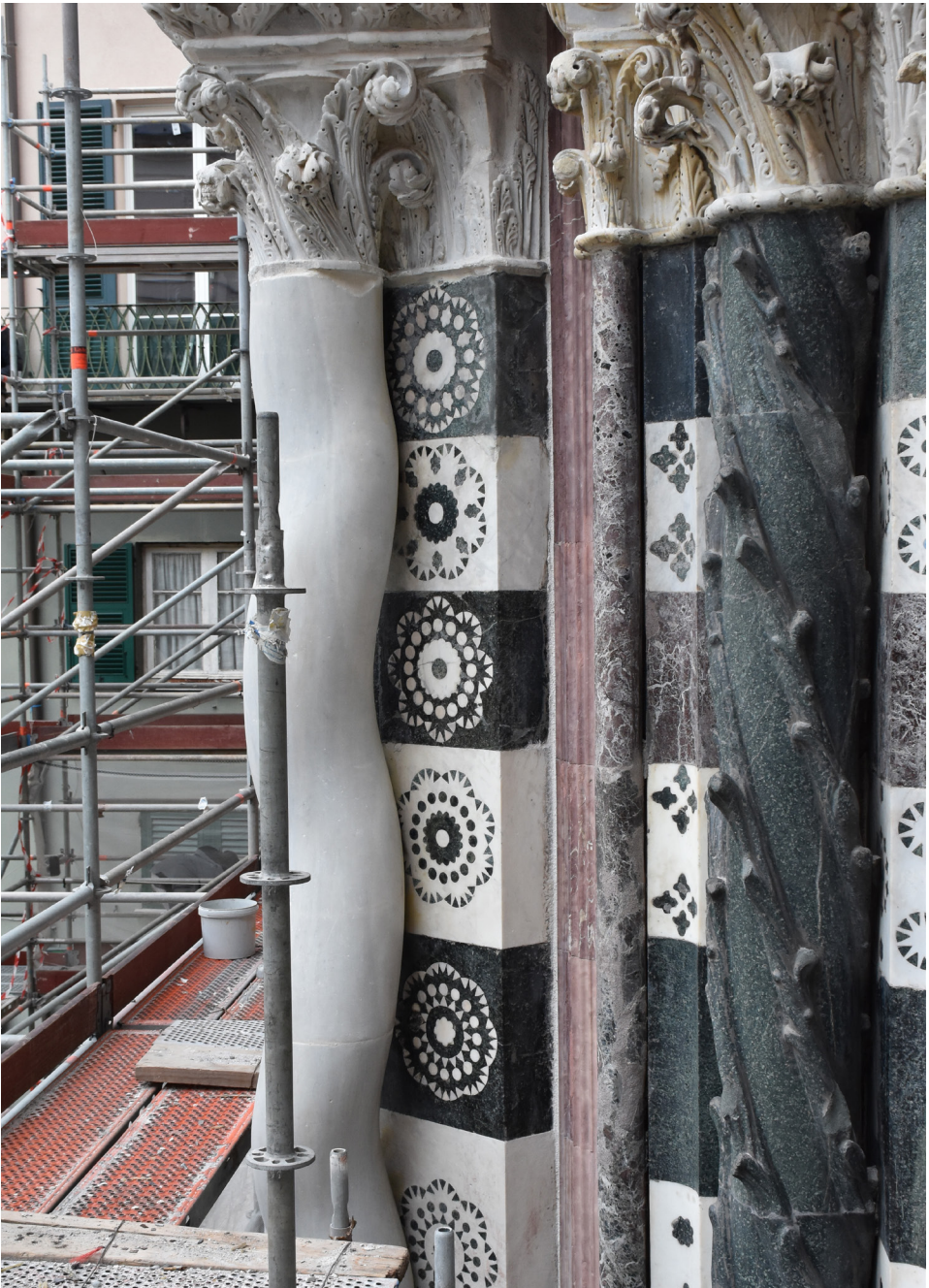
Fig. 7. Particolare della zona centrale della parte destra della facciata con uno dei “virgulti” in Peridotite Verde, uno dei profili in Rosa di La Spezia e gli intarsi della parete di fondo.
