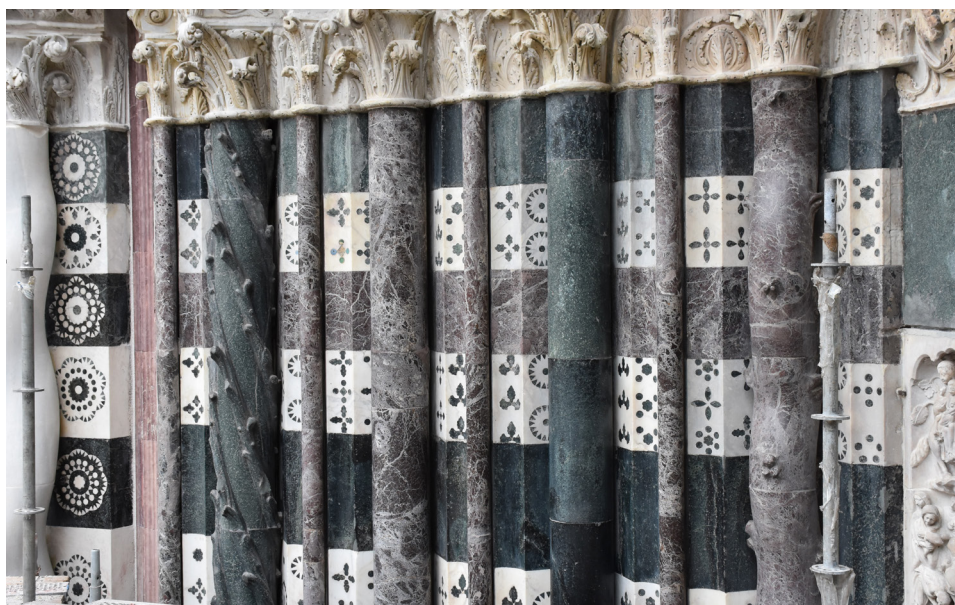
Fig. 12. Particolare della zona centrale della facciata con la parete di fondo eseguita a tarsie.
